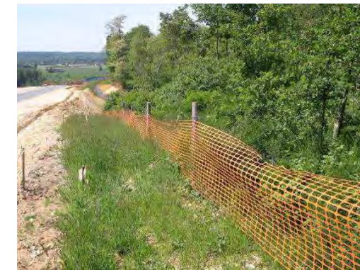
Photographie 7 : Barrière-type de confinement d'emprise de chantier (Source : Egis)
