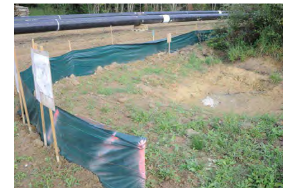
Photographie 12 : Coude de retournement en limite d'emprises du chantier (© Egis)
