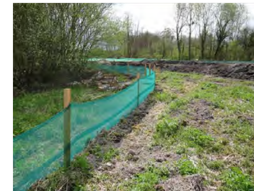
Photographie 11 : Exemple de fixation de bavolet et barrières anti-intrusion posées (© Egis)
