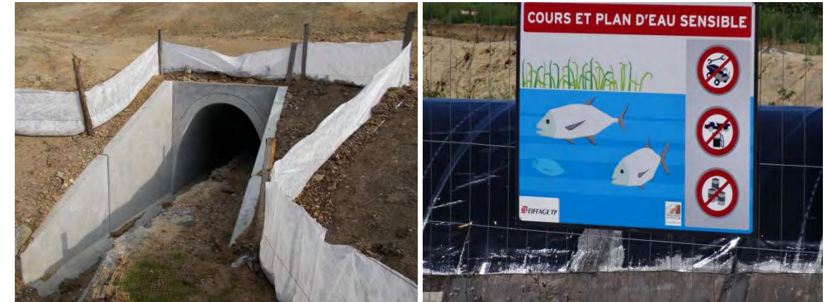
Photographie 19 : Principe d'implantation de clôtures géotextile pour protéger le cours d'eau du Cancaval et les milieux avoisinants et panneau de sensibilisation (© Egis / D. Ferreira)
