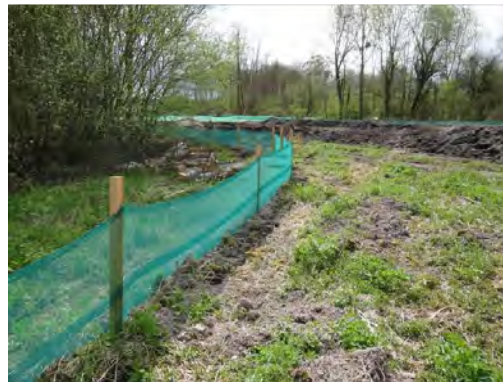
Photographie 2 : Exemple de barrières anti-intrusion posées (© Egis)
