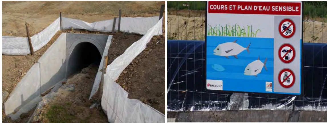
Photographie 1 : Principe d'implantation de clôtures géotextile pour protéger l'affluent du ruisseau du Cancaval et panneau de sensibilisation (© Egis / D. Ferreira)
