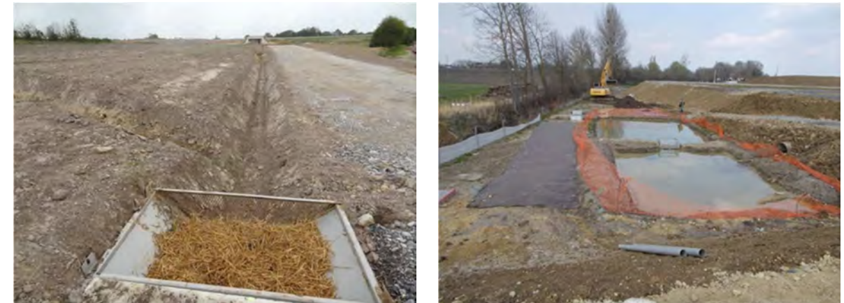
Figure 42 : Exemples de dispositifs d'assainissement provisoire mis en place en phase travaux (© Egis / D. Ferreira)
