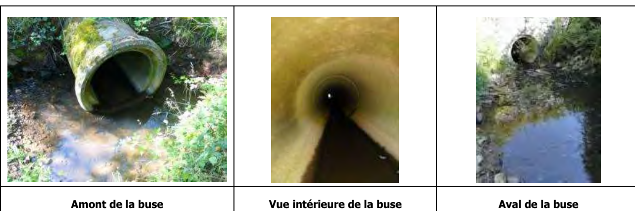
Photographies de la buse de la traversée de la RN164 par le ruisseau de Cancaval 22/07/14
