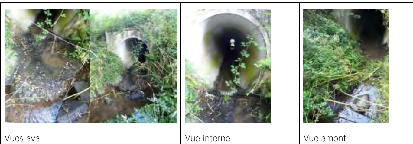
Photographies de la buse du ruisseau de Pont Herva - traversée de la RN164.22/07/14
