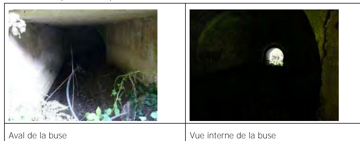
Photographies de la buse du ruisseau de Pont Herva - traversée de la bretelle de sortie vers la RD6a. 22/07/14
