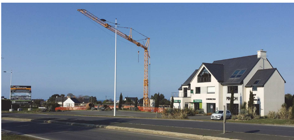
Construction de l'immeuble de bureaux en cause, après destruction de la maison d'habitation encadrée sur la photo aérienne (photo : Olivier Lozachmeur).
