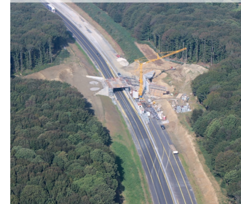
Construction du passage grande faune de Rostrenen @Drone Expérience
