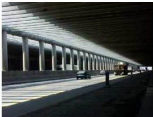
Illustration 9: Photo d'un structure de type auvent
