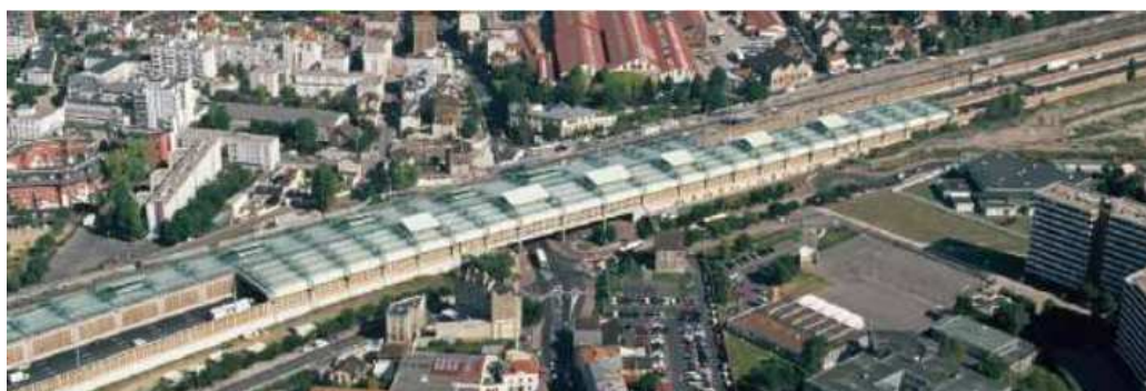
Illustration 13 : Photo aérienne d'une couverture destinée à protéger une infrastructure routière
