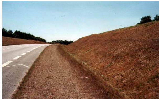
Illustration 3 : Photo d'un merlon destiné à la protection acoustique
