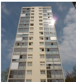
L'immeuble square de Stockholm à Rennes (64 logements) après les travaux d'amélioration qui ont permis de gagner une classe énergétique
