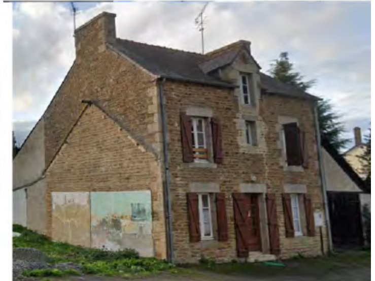
Biens à démolir rue de la Corderie
