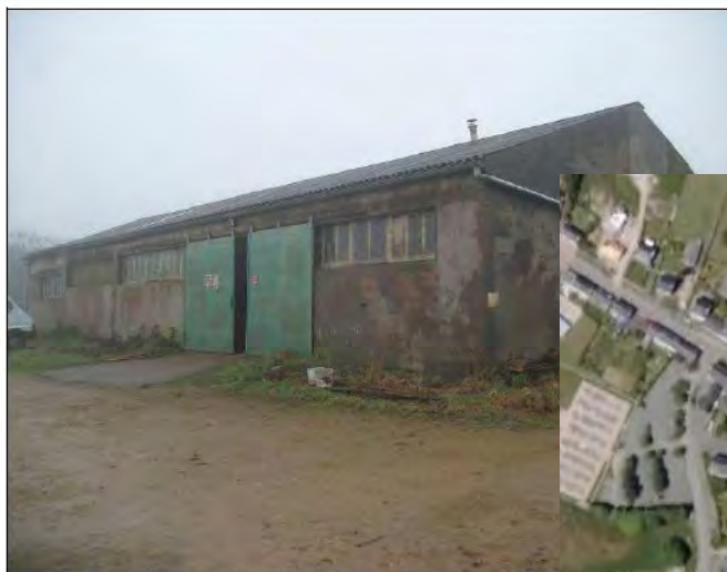
Vue sur le bâtiment abritant les ateliers de travail
