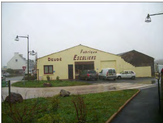
Vue d'ensemble sur le bâtiment abritant les bureaux et ateliers
