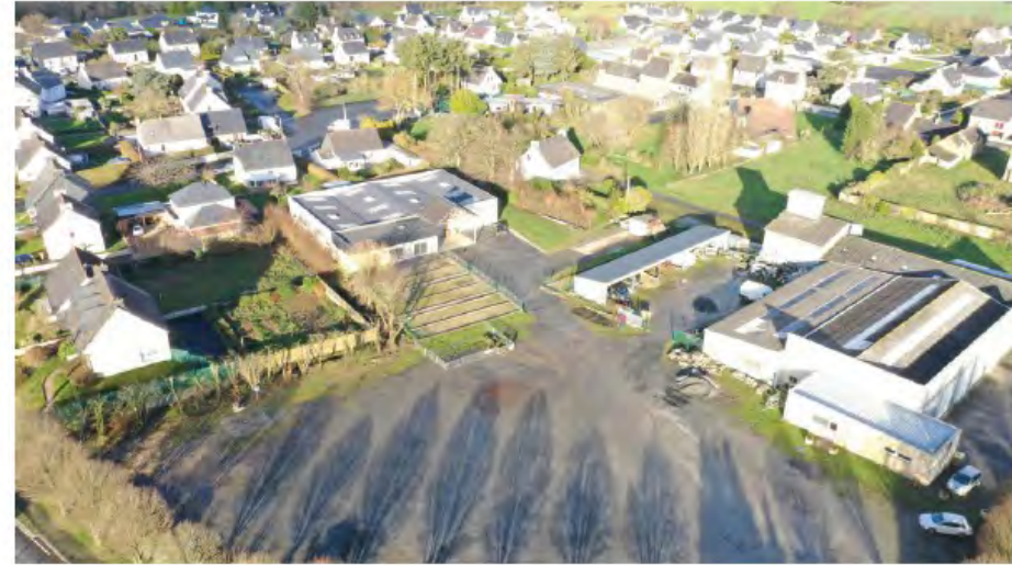
VUE SUD OUEST
