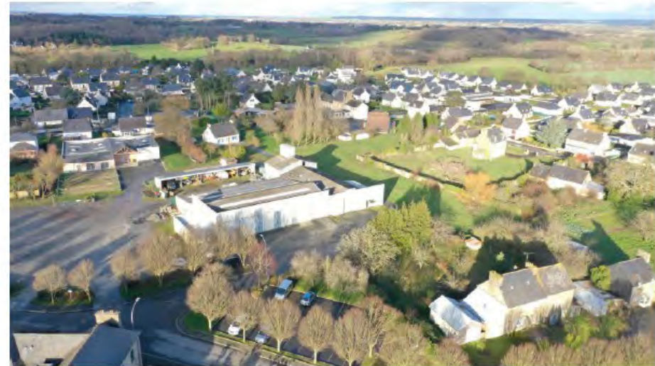
VUE SUD OUEST
