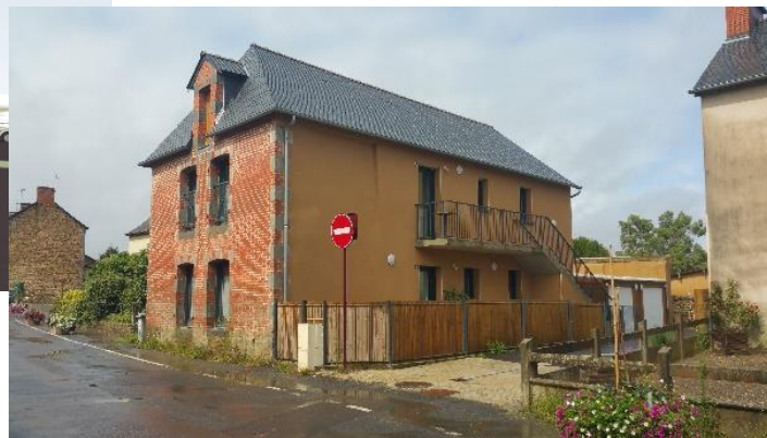
4 logements locatifs sociaux à Guipel – centre bourg
